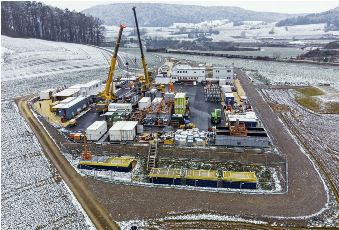
Mit Probebohrungen wie hier unweit von Stadel hat die Nagra die tiefen Gesteinsschichten untersucht. Das Zauberwort hiess dabei: Opalinuston. Nach heutigem Kenntnisstand eignet er sich für die Einlagerung radioaktiver Abfälle.
